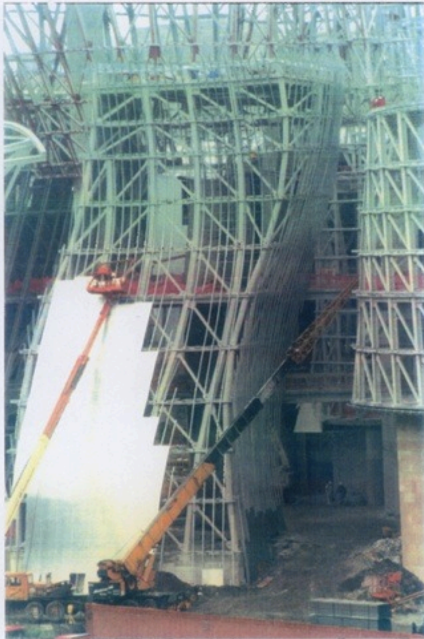
Colocación de chapa galvanizada en "M-5: Boot"
