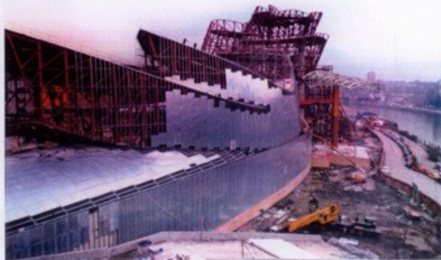
Envolverte de Chapa Galvanizada en el "M-3: T-1000".
