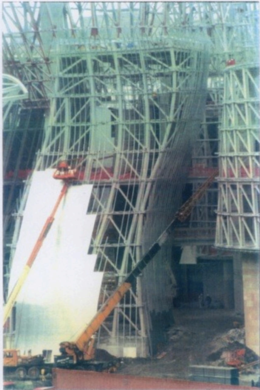
Colocación de chapa galvanizada en "M-5: Boot"
