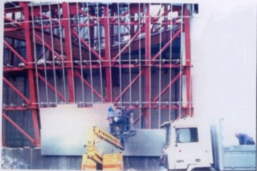
Montaje Envolverte de Chapa Galvanizada en el "M-3: Fish".
