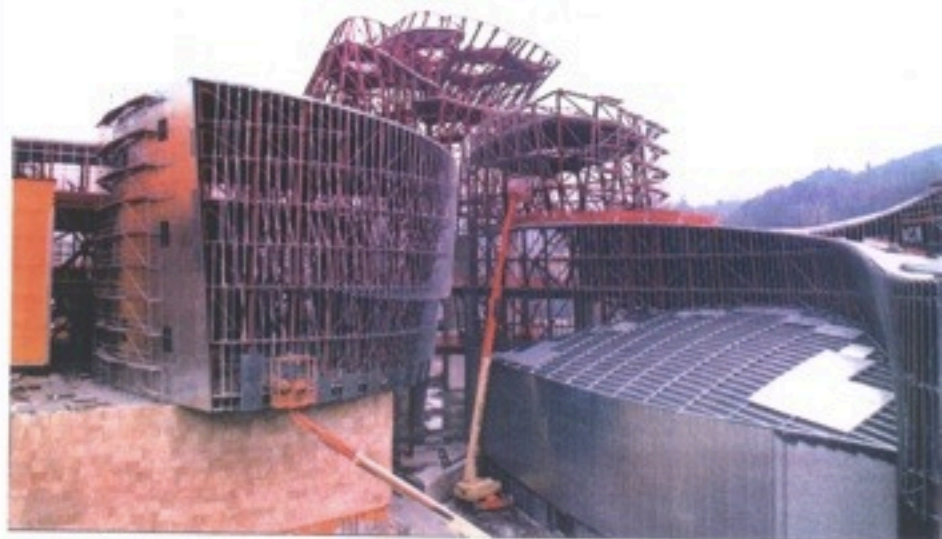
Vista Parcial de Obra.
